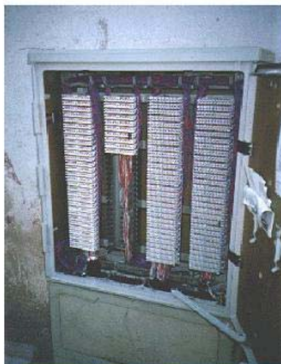
Figura 37- Exemplo de um RG-PC colocado em pedestal
