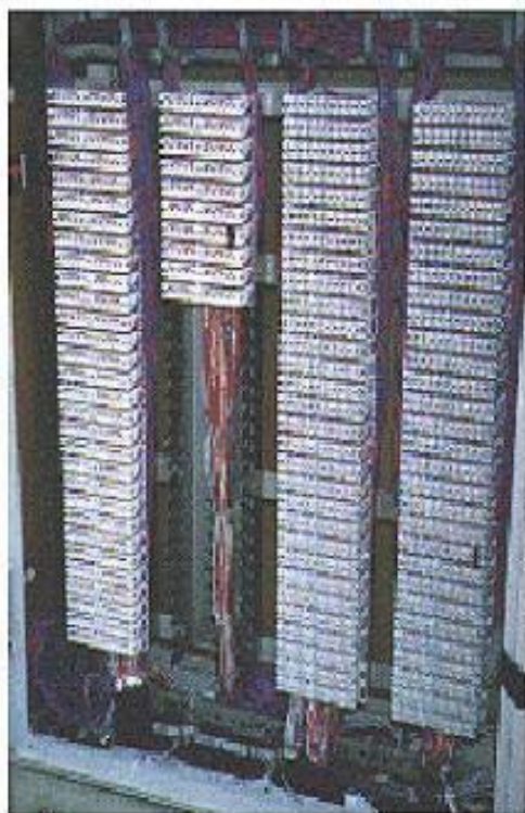
Figura 36- Exemplo de um RG-PC colocado em caixa embuda na parede
